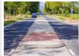
Overrijdbare middengeleider printbeton
