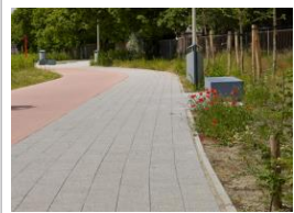
Voetpad Betonstraatstenen (Kekepad – Visbeeklaan)
